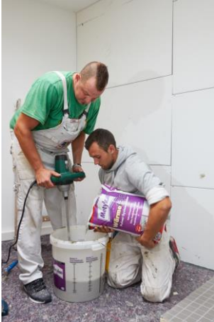
Der WärmePUR System-Pulverkleber gleicht kleinere Wandunebenheiten zuverlässig aus.
