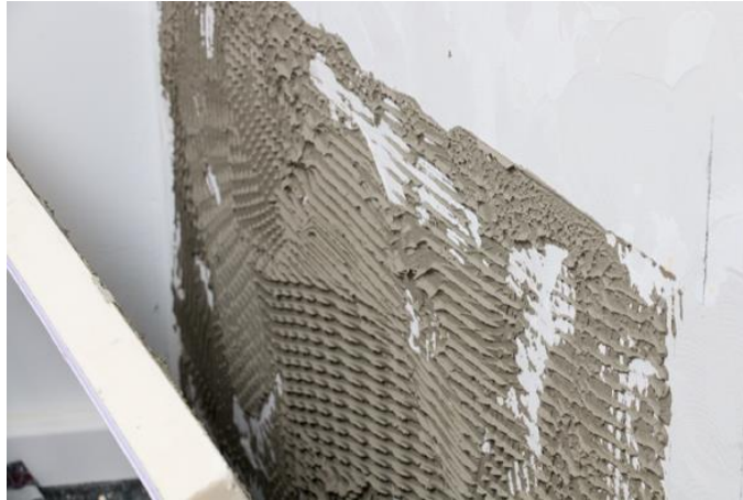
Der WärmePUR System-Pulverkleber gleicht kleinere Wandunebenheiten zuverlässig aus.
