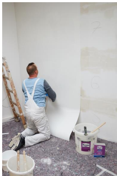
Spachtelarbeiten. Das Renoviervlies wurde verklebt.
