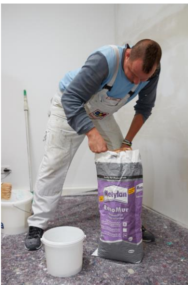
Spachtelarbeiten. Das Renoviervlies wurde verklebt.
