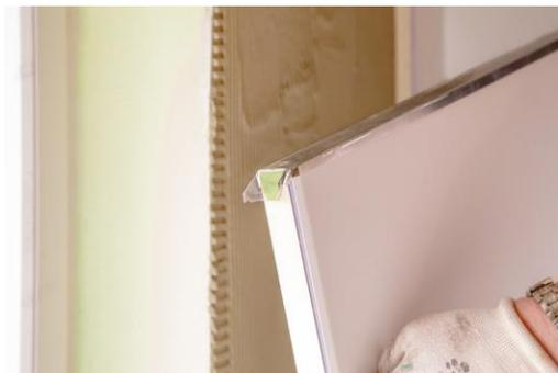
Die Fensterlaibungen wurden zur Einschärfung der thermischen Übergänge mit den WärmePUR Laibungsplatten versehen.
