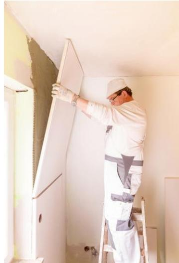
Zum Verkleben der Dämmplatten nutzten die Profis den WärmePUR System-Pulverkleber.
