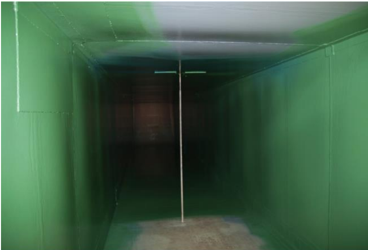
Der Rauchgaskanal während der Beschichtung
