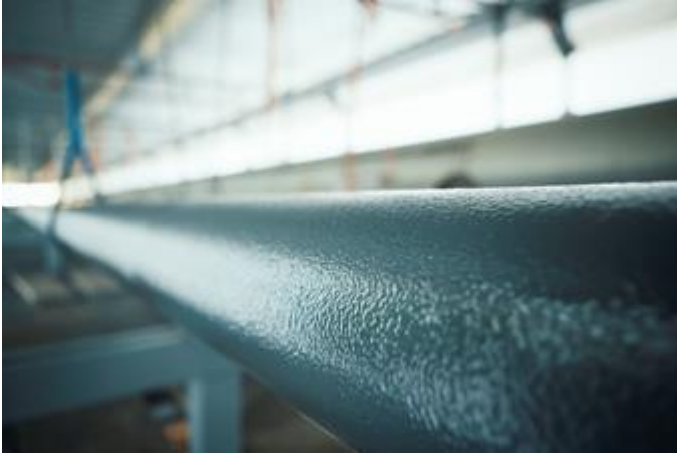
Stahlrohrleitung nach der Beschichtung mit LOCTITE PC 7255 sprühbare Keramikbeschichtung als schützende Deckschicht
