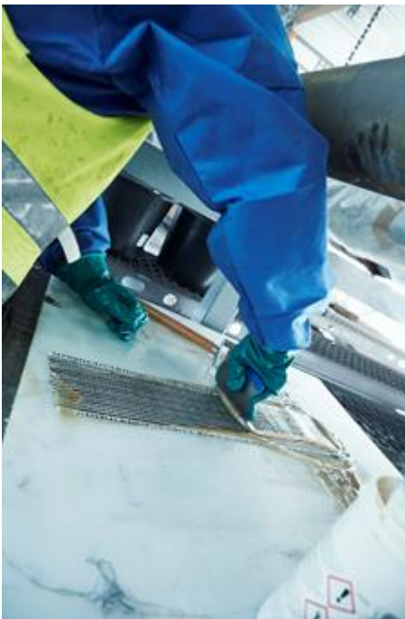
LOCTITE PC 7210 wird auf das Glas-Carbon-Gelege aufgetragen
