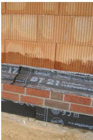
Ob wie hier im Sockelbereich, an Gebäudeecken oder Fenster- und Türöffnungen: Die BT 21 Dichtbahn Allwetter hält dicht. (Foto: Ceresit Bautechnik)
