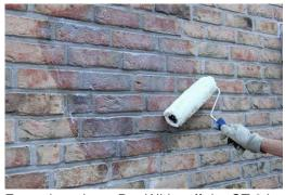
Fassadenschutz: Der Wirkstoff der CT 8 Imprägniercreme dringt tief in das Mauerwerk ein und ist dauerhaft wasserabweisend. (Foto: Ceresit Bautechnik)
