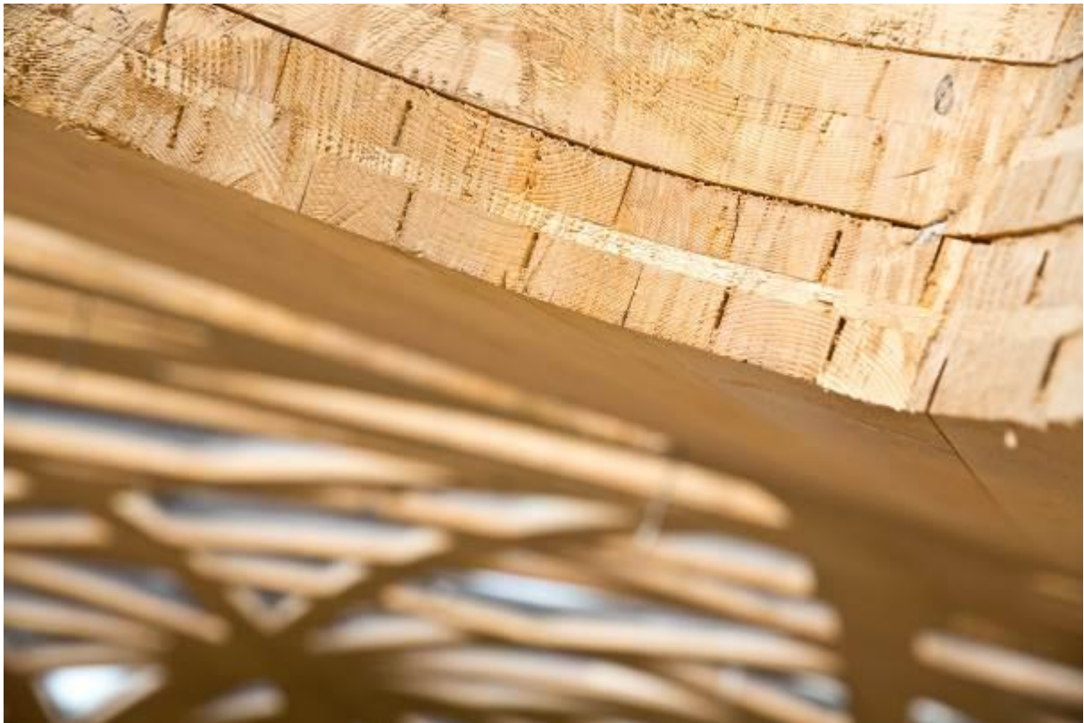
Mit Loctite Purbond verleimte Holzelemente des Daches.
