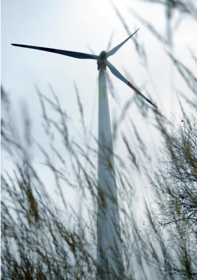
Der TimberTower in Hannover wurde mit Klebstoffen der Marke Loctite (ehemals Purbond) aus Holz errichtet.
