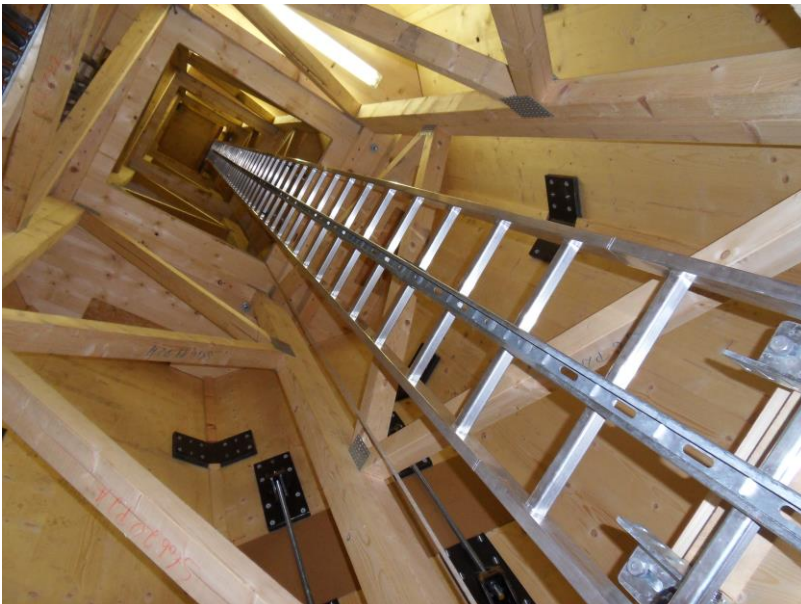
Innenansicht der verklebten Holzkonstruktion des TimberTower.
