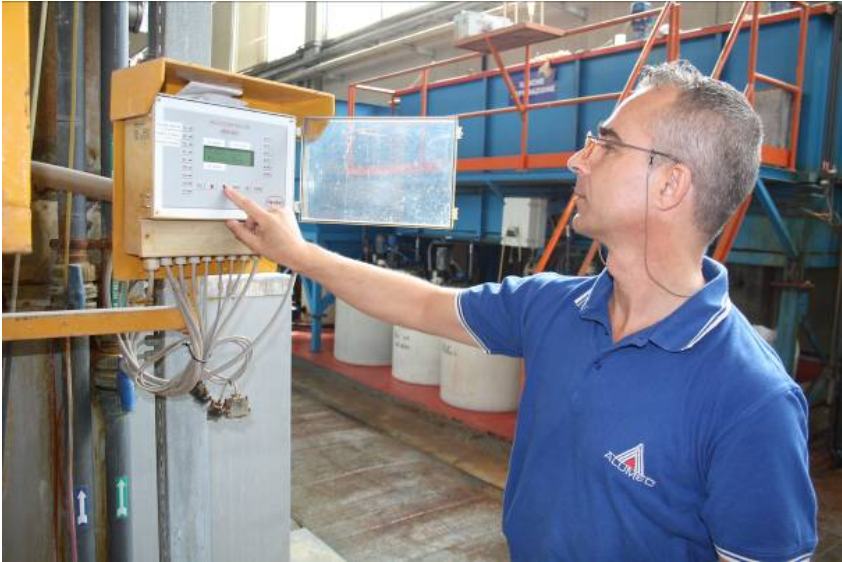
Alumec-Ingenieur Giulio Marianelli bei der Kontrolle der Anlagenfunktion.
