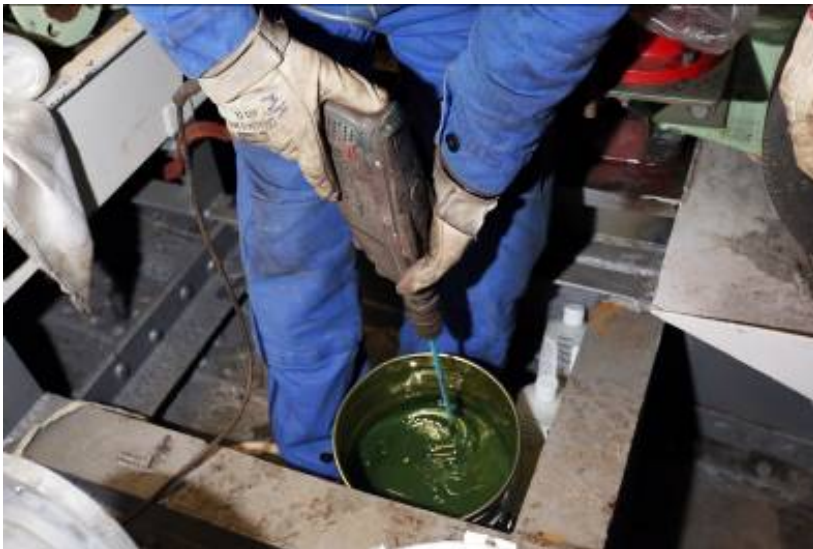
Die beiden Komponenten des Loctite Fixmaster Marine Chocking werden mittels eines Mixstabs angerührt
