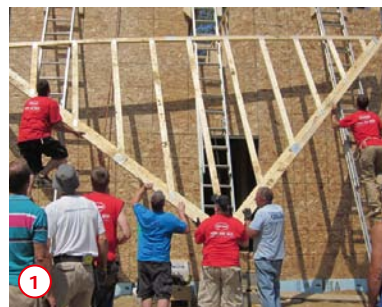
USA: Henkel-Mitarbeiter Jim Walkup und Kollegen vom Standort Westlake in Ohio packten in ihrer Freizeit mit an, Häuser im Großraum Cleveland zusammen mit der Organisation Habitat for Humanity zu bauen. MIT stiftete zusätzlich Produkte für den Bau. Ziel von Habitat for Humanity ist es, ärmliche Behausungen und Obdachlosigkeit durch Häuserbau zu beseitigen. www.habitat.org
