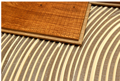
Behutsam werden die bis zu 3,5 Meter langen Dielen in das Klebstoffbett eingelegt (Thomsit 13a-c).
