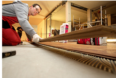
Behutsam werden die bis zu 3,5 Meter langen Dielen in das Klebstoffbett eingelegt (Thomsit 13a-c).
