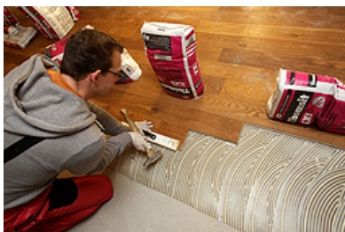
Im Klebstoffbett wird die zuletzt eingelegte Diele angeschlagen (Thomsit 15).
