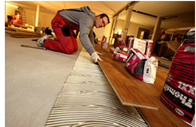
Behutsam werden die bis zu 3,5 Meter langen Dielen in das Klebstoffbett eingelegt (Thomsit 13a-c).
