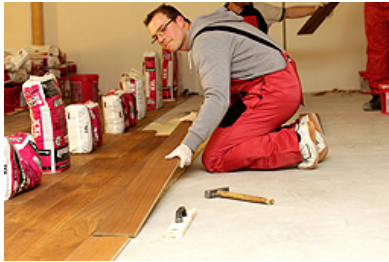
Behutsam werden die bis zu 3,5 Meter langen Dielen in das Klebstoffbett eingelegt (Thomsit 13a-c).
