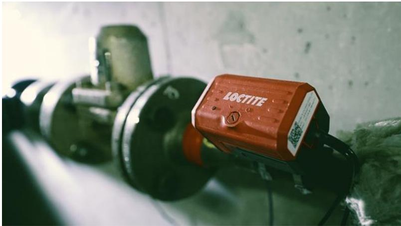
Mit einer Reihe von einfach zu installierenden Nanosensoren, die am Ein- und Ausgang des Kondensatableiters angebracht werden, sammelt die neue Loctite Pulse Lösung kontinuierlich Informationen über den Anlagenzustand.
