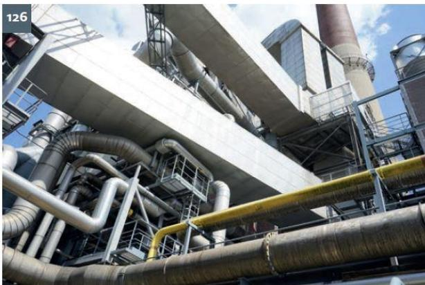
Durch Schwefel- und Stickstoffverbindungen sowie Kondenswasser ist der Rauchgaskanal des Henkel-Kraftwerks extremer Korrosion ausgesetzt.
