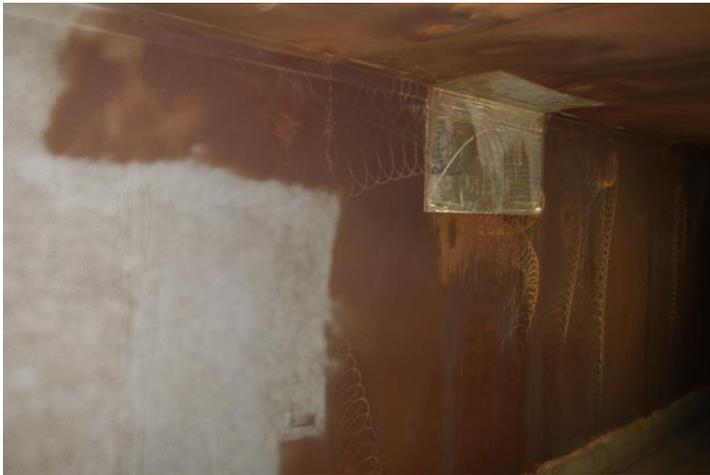
Aufnahme 2015 vor der Beschichtung mit Loctite PC 7255: Schwefelsäure korrodiert den Stahl.
