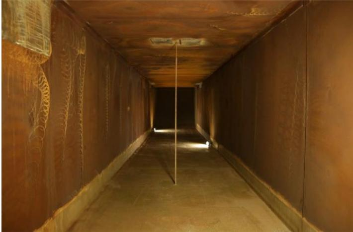
Der Rauchgaskanal des fabrikeigenen Kraftwerks vor der Beschichtung im Jahr 2015.
