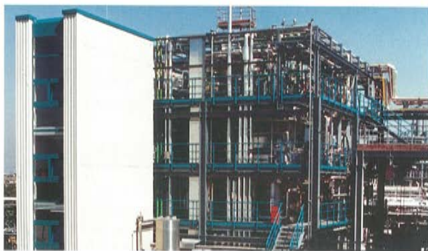
Weltneuheit im Düsseldorfer „Ölviertel“: die Anlage zur kontinuierlichen Fettsäure-Härtung.
