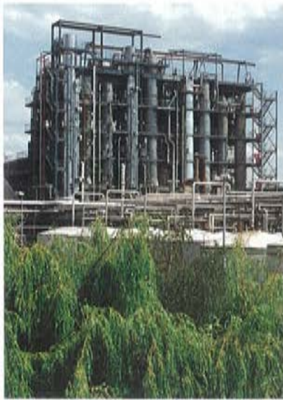
Bei der Verarbeitung von tierischen Fetten in der fettchemischen Produktion, hier in Düsseldorf, besteht aufgrund der hohen Temperaturen und Drücke kein BSE-Risiko.
