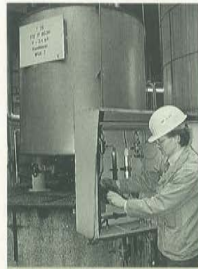
Im Sammelbehälter (hinten) wird heißes Kondensat aufgefangen.
