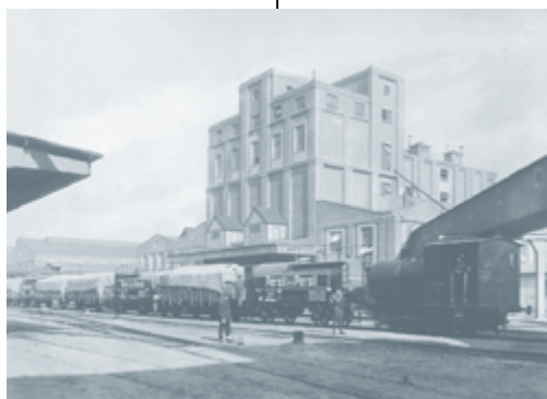
„Krause-Anlage“ in Holthausen
