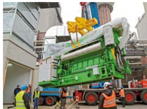
Anlieferung der Zwölf-Zylinder-Motoren für die beiden neuen Blockheizkraftwerke in Düsseldorf-Holthausen
