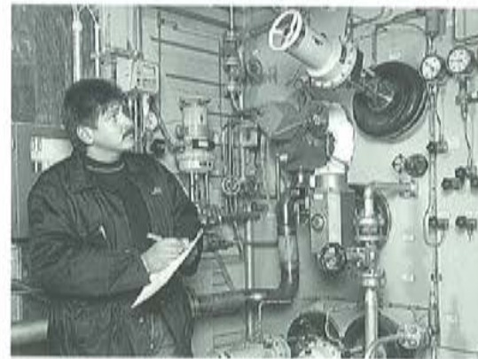
Ein Linde-Mitarbeiter inspiziert die Luftzerlegungsanlage im Stammwerk.
