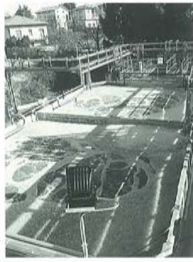
Das Belüftungsbecken der biologischen Abwasserbehandlung in Fino Mornasco.
