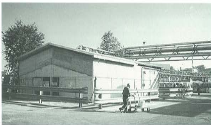
Das neue Tanklager der Henkel Chimica in Fino Mornasco.
