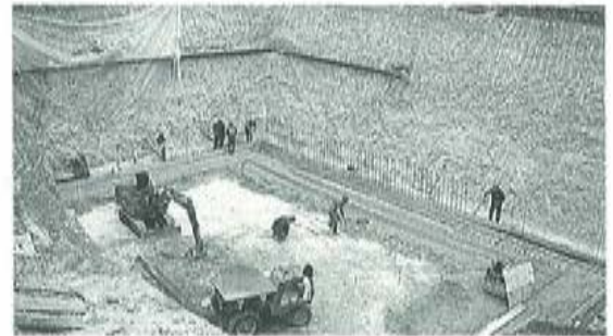
Reims: Zusätzliche Auffangtassen vergrößern die Rückhaltekapazität.
