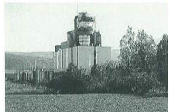
Atalanti: Ein Turmaufsatzfilter sorgt für staubfreie Abluft.
