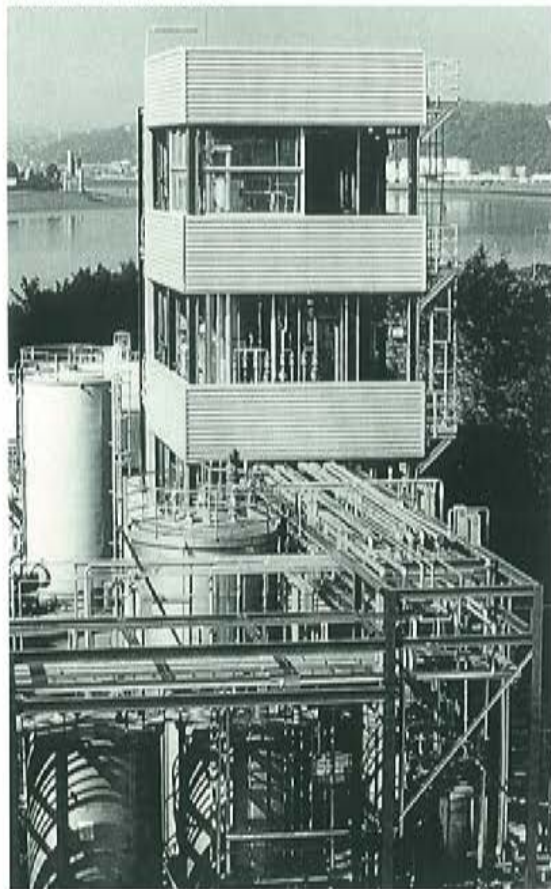
In der neuen Aufbereitungsanlage der Henkel Ireland wird Essigsäure mit einem Reinheitsgrad von 99,5 Prozent aus Abwasser extrahiert.
