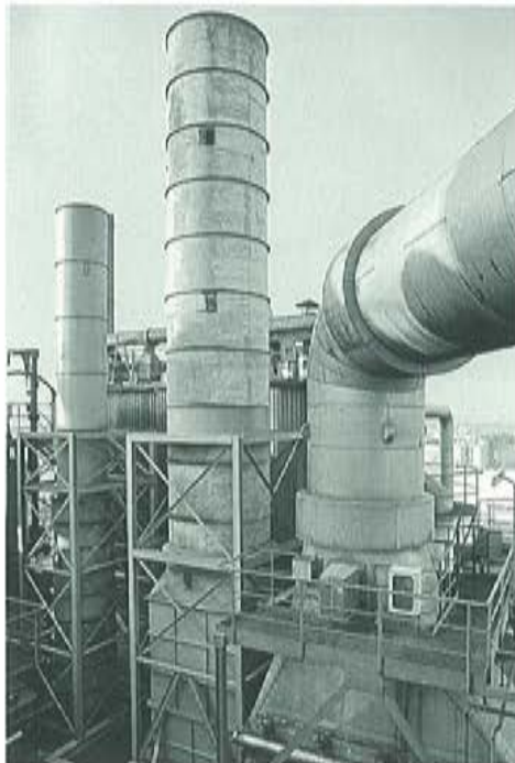
Fünf Tonnen schwer und sechs Meter hoch ist der Dämpfer, den ein Waschmittel-Zerstäubungsturm 1993 in Düsseldorf verpaßt bekam.
