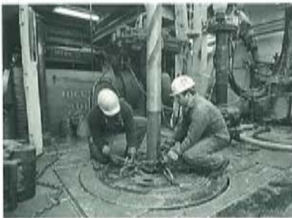
Auf der Bohrplattform wird das Bohrgestänge verlängert. Mit gegeneinander rotierenden Mehrfach-Zahnkränzen fressen sich die Bohrköpfe auch durch härtestes Gestein.
