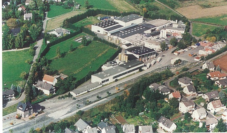
Vorsorgemaßnahme bei der Henkel Oberflächentechnik in Herborn-Schönbach: Eine automatische Meßstation überwacht den Regenwasserkanal.
