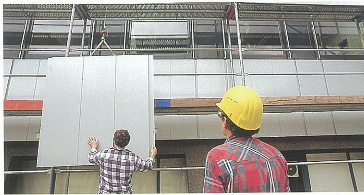
Weltpremiere bei Henkel in Düsseldorf: das erste Gebäude, bei dem Fassade und Fenster aus Aluminium in einem chromfreien Prozeß vorbehandelt und lackiert wurden.
