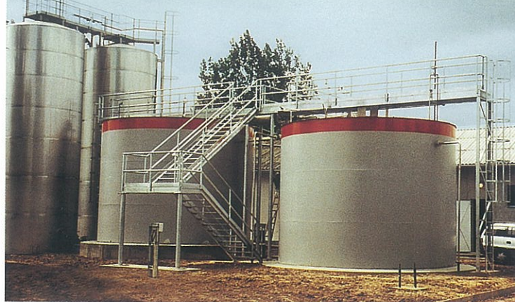
Saubere Sache: Henkel Magyarorszag hat im Werk Körösladány eine eigene Abwasserreinigungsanlage in Betrieb genommen.
