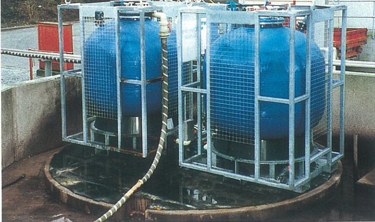
Frühere Produktionsabfälle verkauft Henkel Ireland jetzt als Wertstoff: Dazu werden organische Verunreinigungen aus wäßrigen Aluminiumsalz-Lösungen entfernt.
