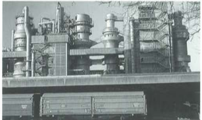
Die Zerstäubertürme der Düsseldorfer Waschmittel-Produktion: Filter senken den Staubanteil der Abluft.
