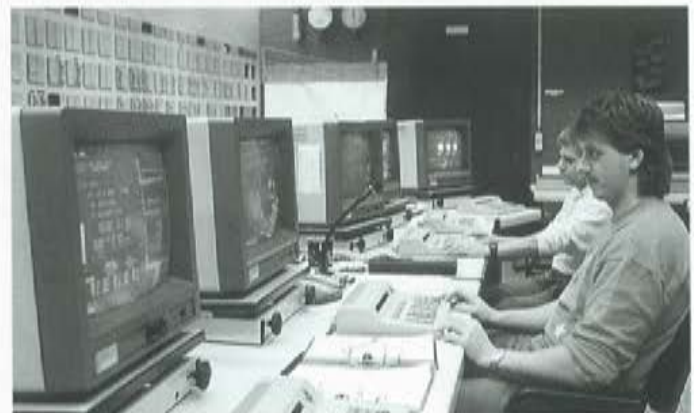
Computergestützte Prozeßsteuerung: eine moderne Meßwarte, hier in der Klebstoff-Produktion.
